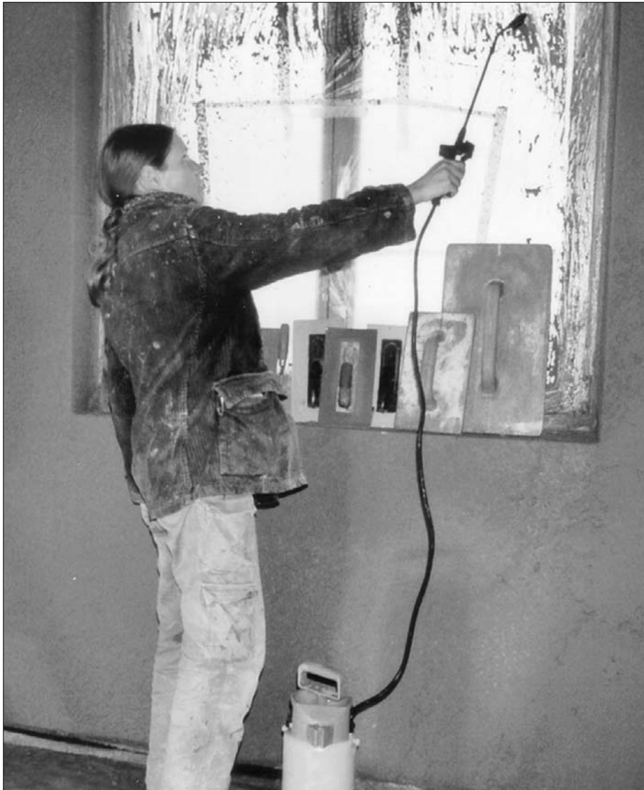
Der Lehmputz wird in Eigenleistung aufgebracht, schafft ein gutes Raumklima und ist zudem noch preiswerter als der herkömmliche Kalkzementputz
